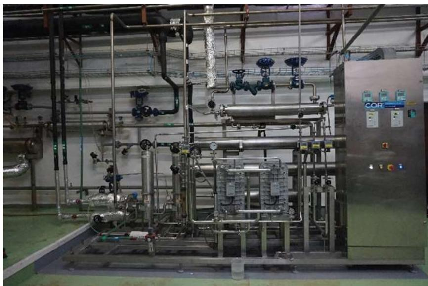
Figura 1.-Equipo de ósmosis inversa instalado en el CIM.
